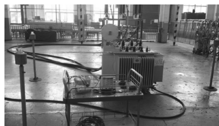
图6 现场温升试验
